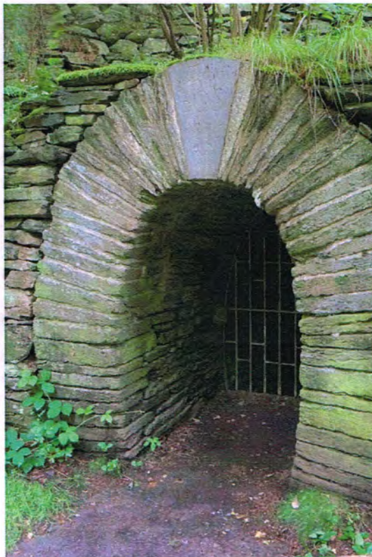
Mundloch des Tiefer Blühend Glück Stollns im Schwarzwassertal
