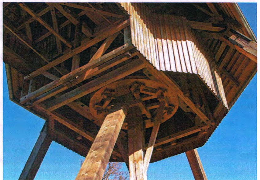
Blick auf die Seiltrommel des Pferdegöpels
